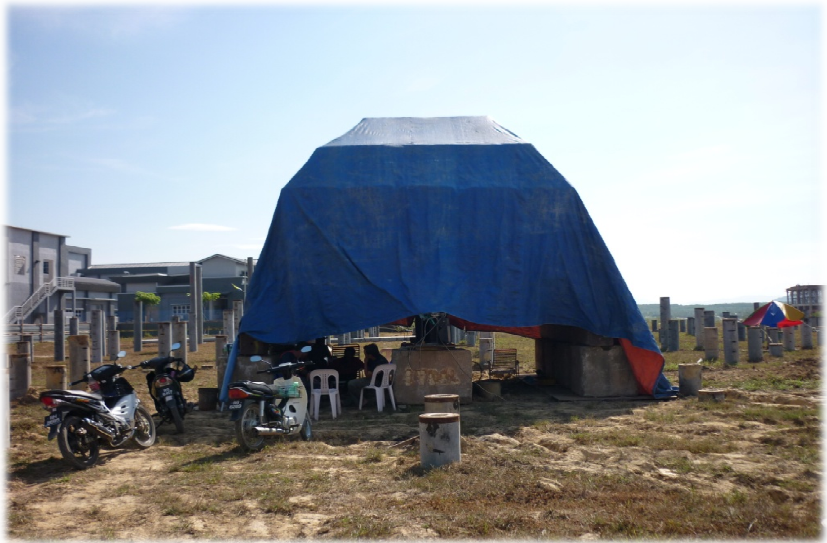
Ujian Beban Statik ( Maintain Load Test )
