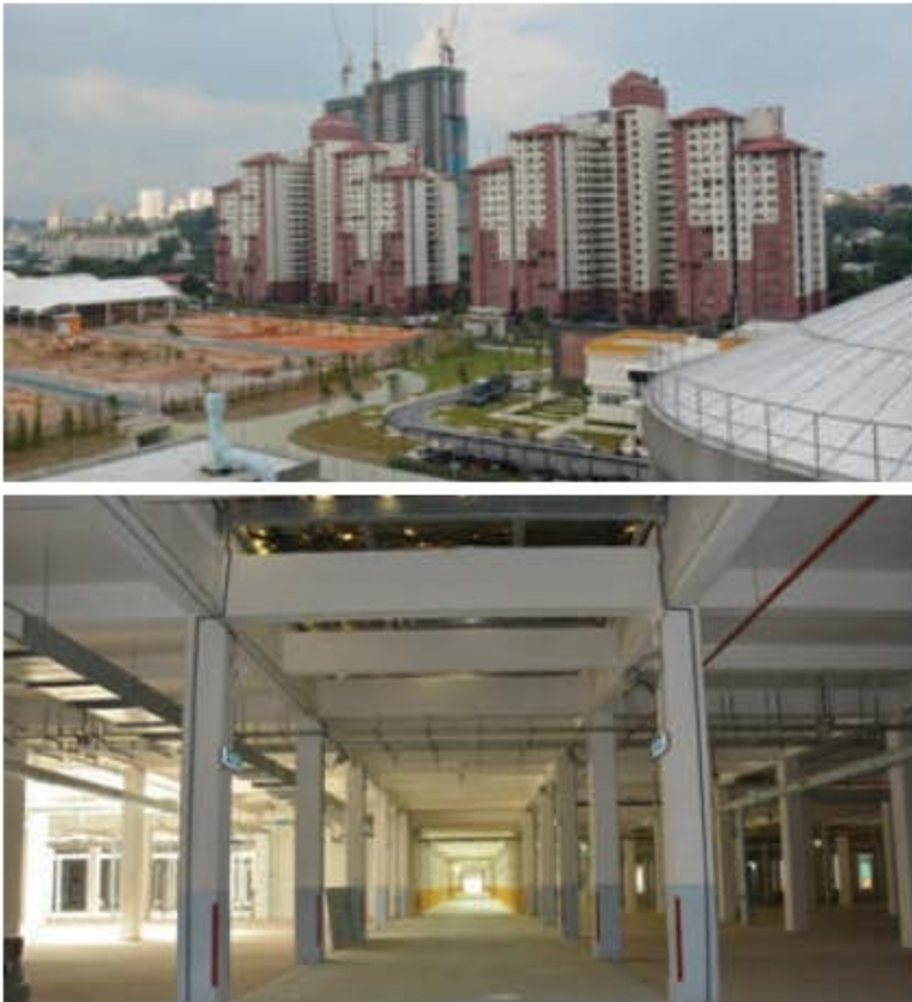
Figure 2: Actual Construction Pantai 2 STP
