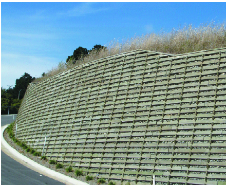
Figure4: Timber crib wall
