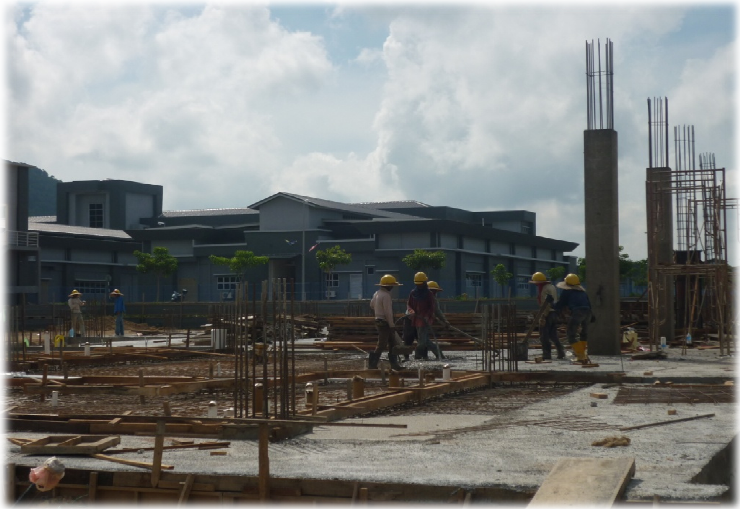
Kerja-kerja pembinaan lantai aras bawah
