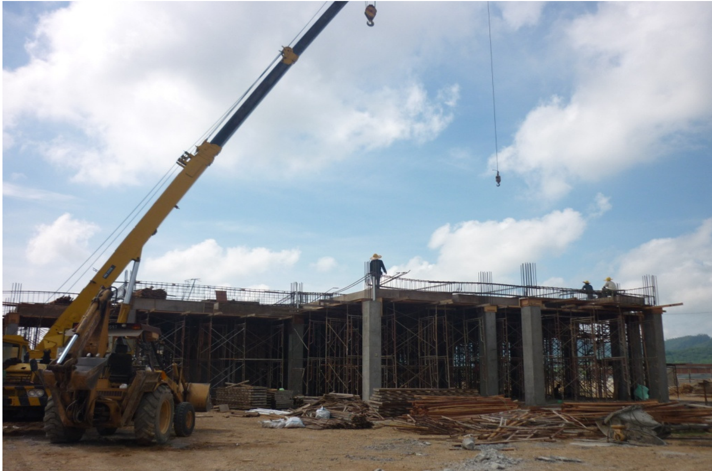
Kerja-kerja pemasangan besi tetulang rasuk aras satu.
