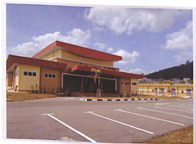
Gambar 6 : Pembinaan Bangunan ICT Data Center (100% Siap).
