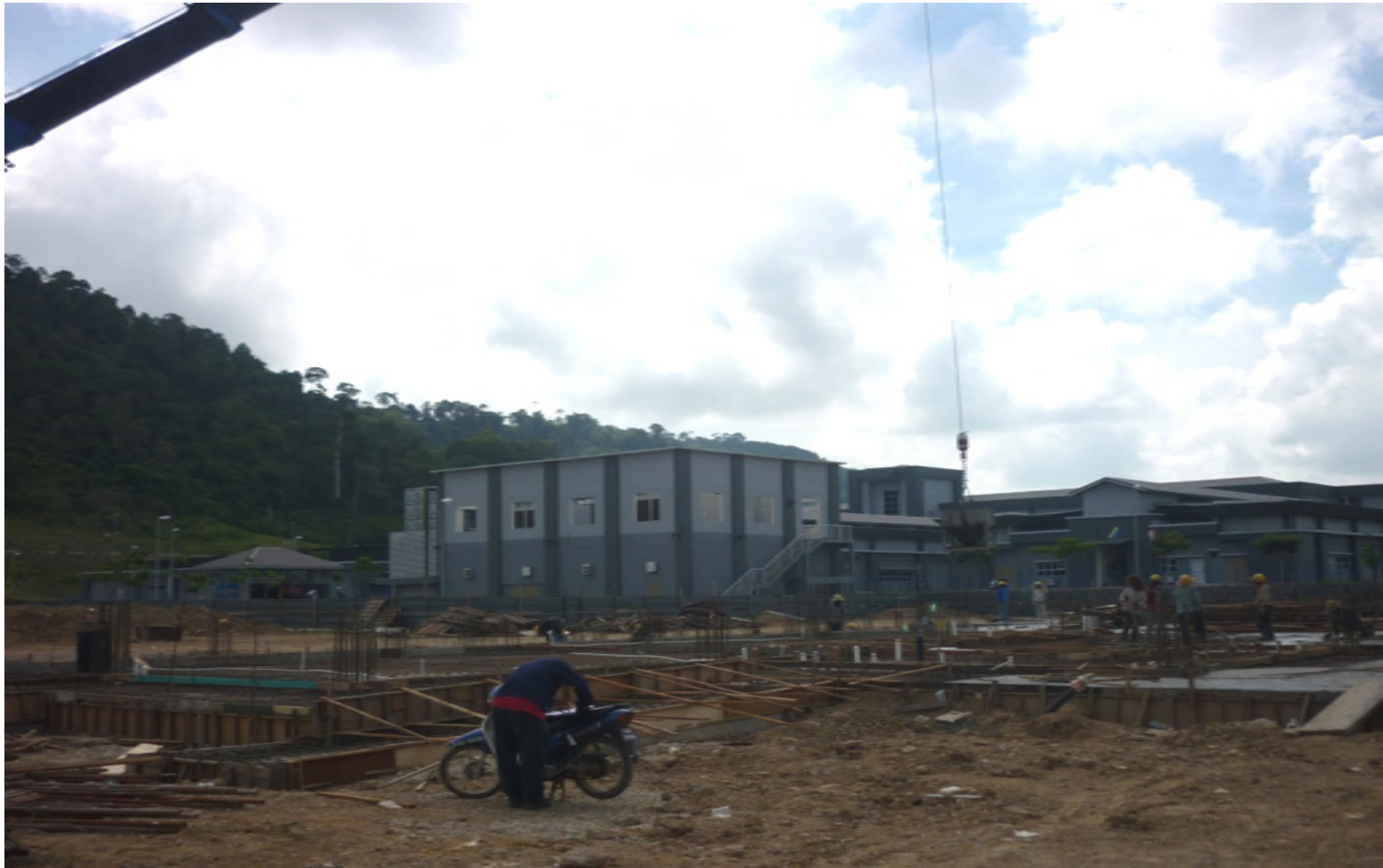
Kerja-kerja pemasangan kotak bentuk lantai aras bawah.
