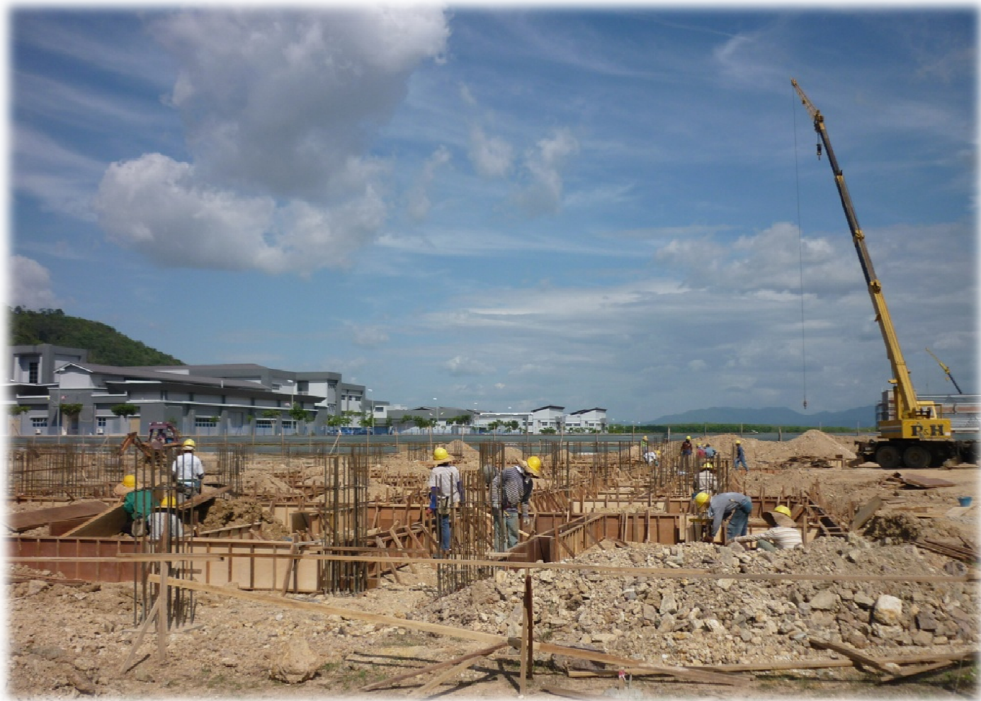
Kerja-kerja pemasangan kotak bentuk dan besi tetulang rasuk tanah
