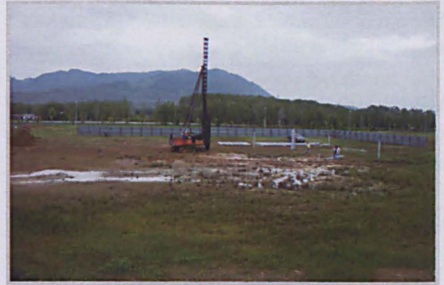
Gambar 16 : Pembinaan Bangunan ICT Data Center (5% Siap).
